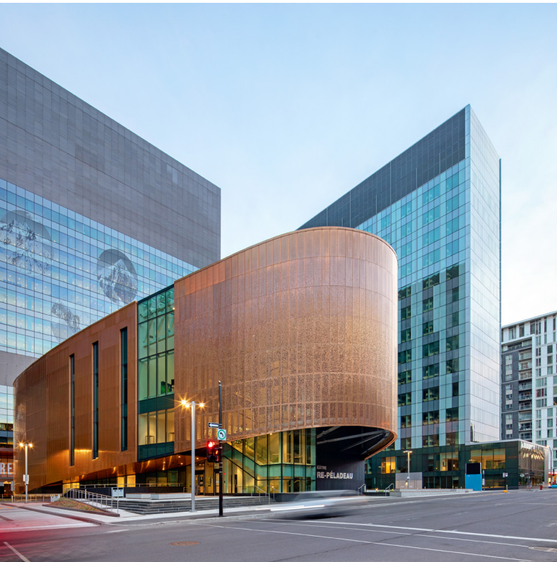
Dernière phase du nouveau complexe hospitalier du CHUM
