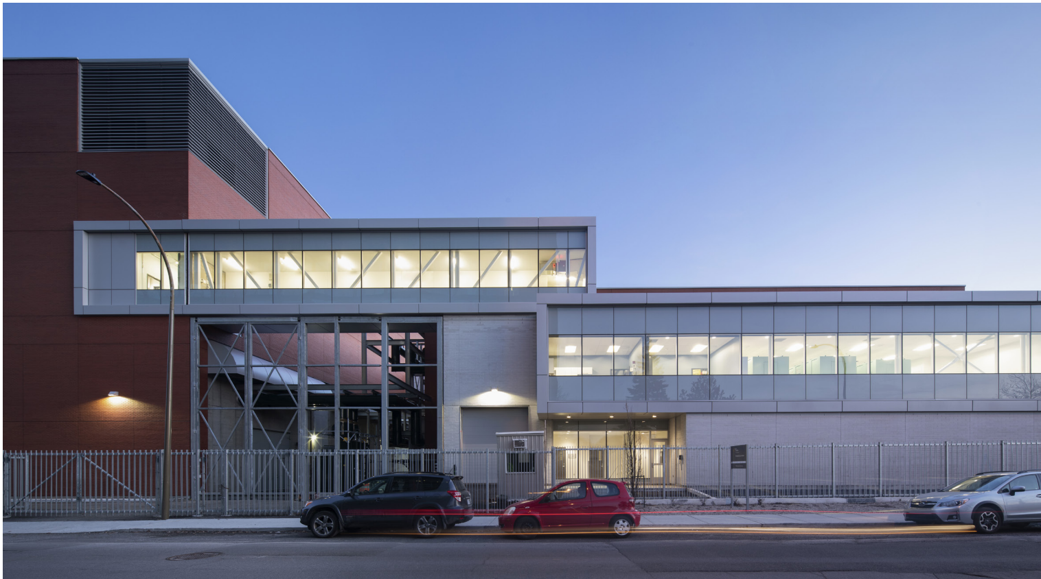
Poste Hydro-Québec De Lorimier 315-25 kV © Adrien Williams
